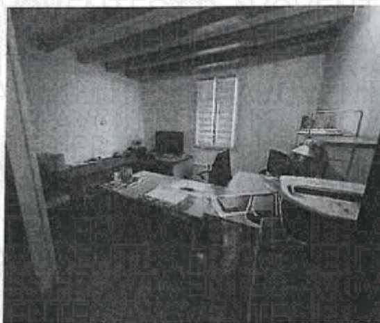
Le plafond est en toile de fibre de verre peinte. La peinture est récente et des poutres bois se situent au plafond, lesquelles sont peintes et en bon état d'entretien.
