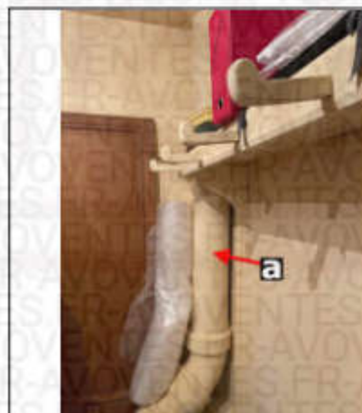
Photo n° PhA004 Localisation : 2ème étage entresol aile sud - Dressing Ouvrage : 6 - Conduits et accessoires intérieurs - Conduits de fluides (air, eau, vapeur, fumée, échappement, autres fluides) Partie d'ouvrage : Conduit en fibres-ciment Description : Conduit en fibres-ciment
