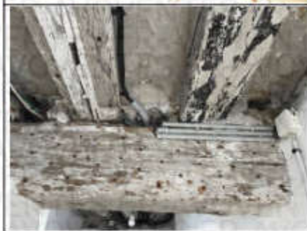
Photo n° PhTer002 Localisation : Rez de chaussée - Couloir 1 Ouvrage : Poutres Parasite : ---- Insectes à larves xylophages ---- Indices : présence de trous de sortie, présence de vermoulure (infestation(s) importante(s), présence étendue) Informations complémentaires : Présence d'un traitement par injection sur les poutres
