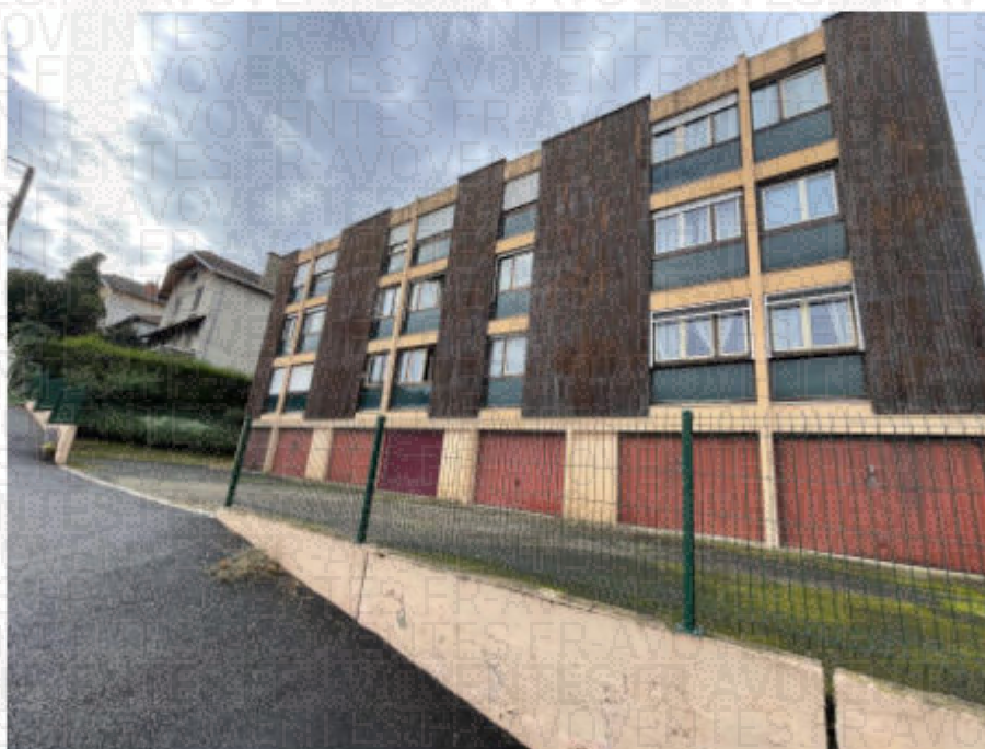
Photo n°2 : vue de la façade.
