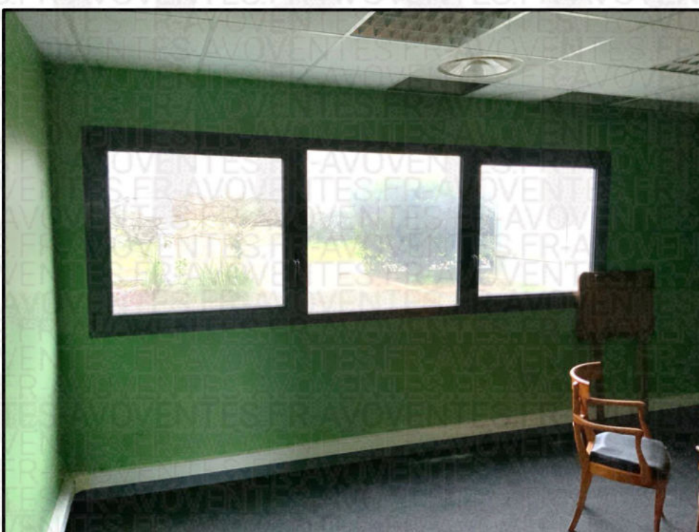
Photographie n°13. Panneau 2 – Vue au Nord
