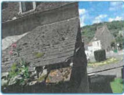
D.O. n° 3 sur Plafond Charpente traditionnelle bois Ardoises composites
