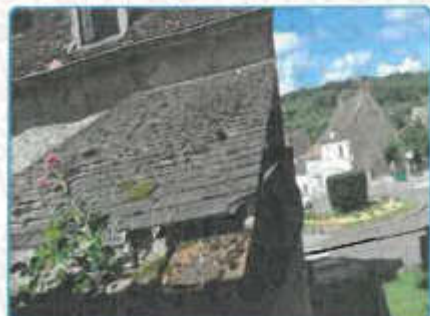
D.O. n° 3 sur Plafond Charpente traditionnelle bois Ardoises composites
