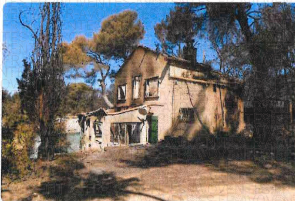
Maison non débroussaillée, partiellement détruite par le passage d'un feu, Ragnac (13), source : ONF.
