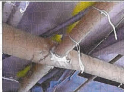
Photo n° PhA001 Localisation : Rez de chaussée - Garage Ouvrage : Flocages, Calorifugeages, Faux plafonds Partie d'ouvrage : Calorifugeages Description : Calorifugeages Localisation sur croquis : M001
