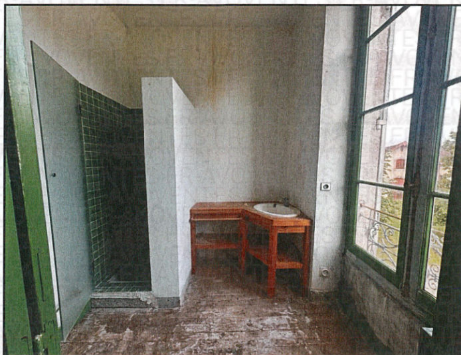
SALLE D'EAU ATTENANTE CHAMBRE 3
