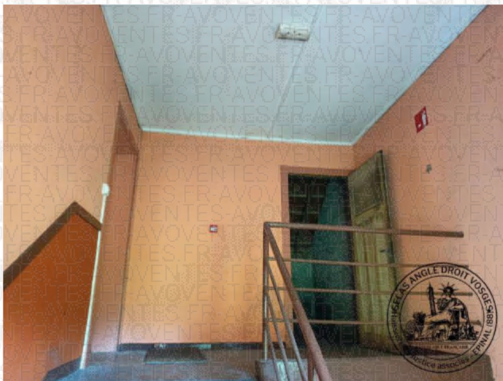
Les parois murales et le plafond présentent d'innombrables marques de salissures noirâtres et prolifération de moisissure.
