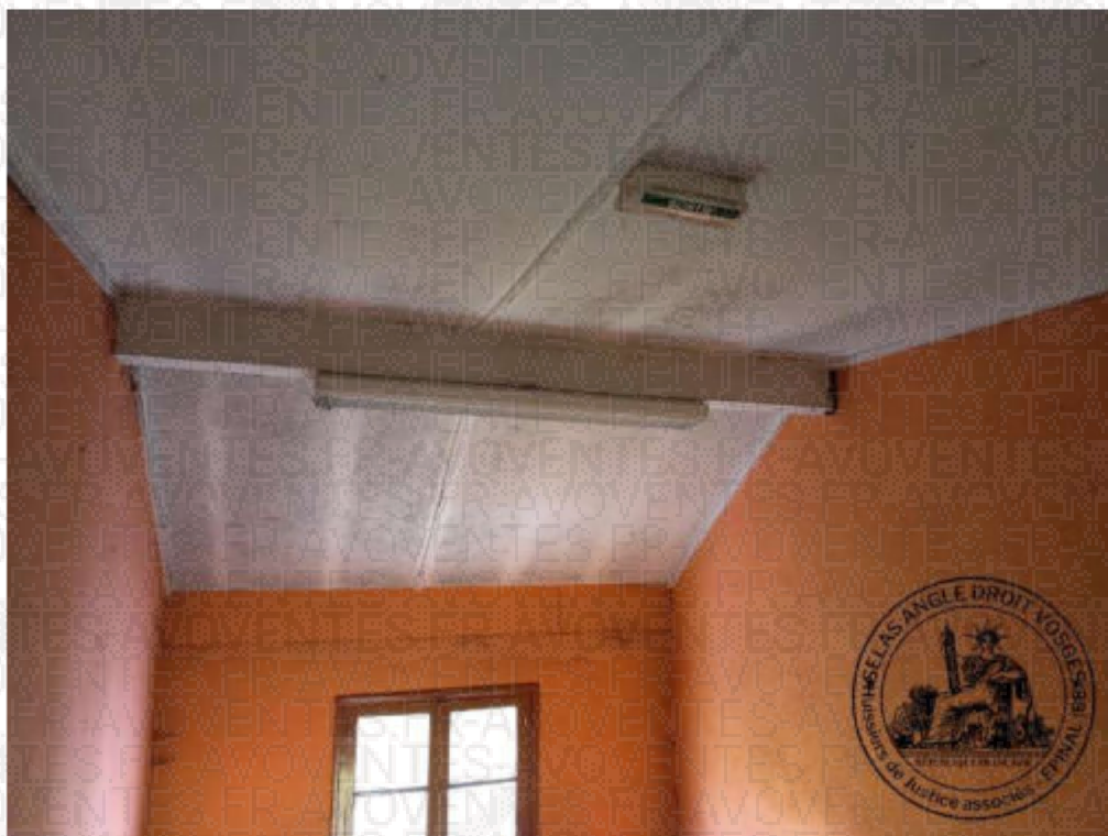
Les parois murales et le plafond présentent d'innombrables marques de salissures noirâtres et prolifération de moisissure.
