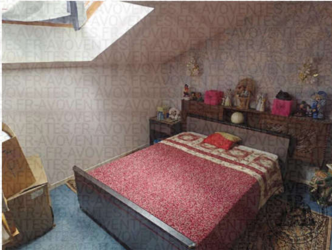
Quelques coulures jaunâtres et noires, avec formation de moisissures au droit de la fenêtre de toit, laissant deviner la présence d'infiltrations.
