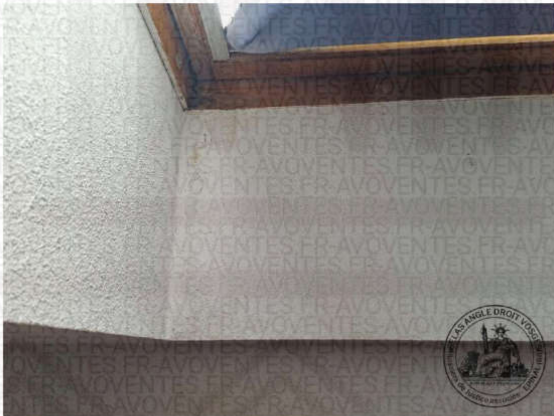
Quelques coulures jaunâtres et noires, avec formation de moisissures au droit de la fenêtre de toit, laissant deviner la présence d'infiltrations.
