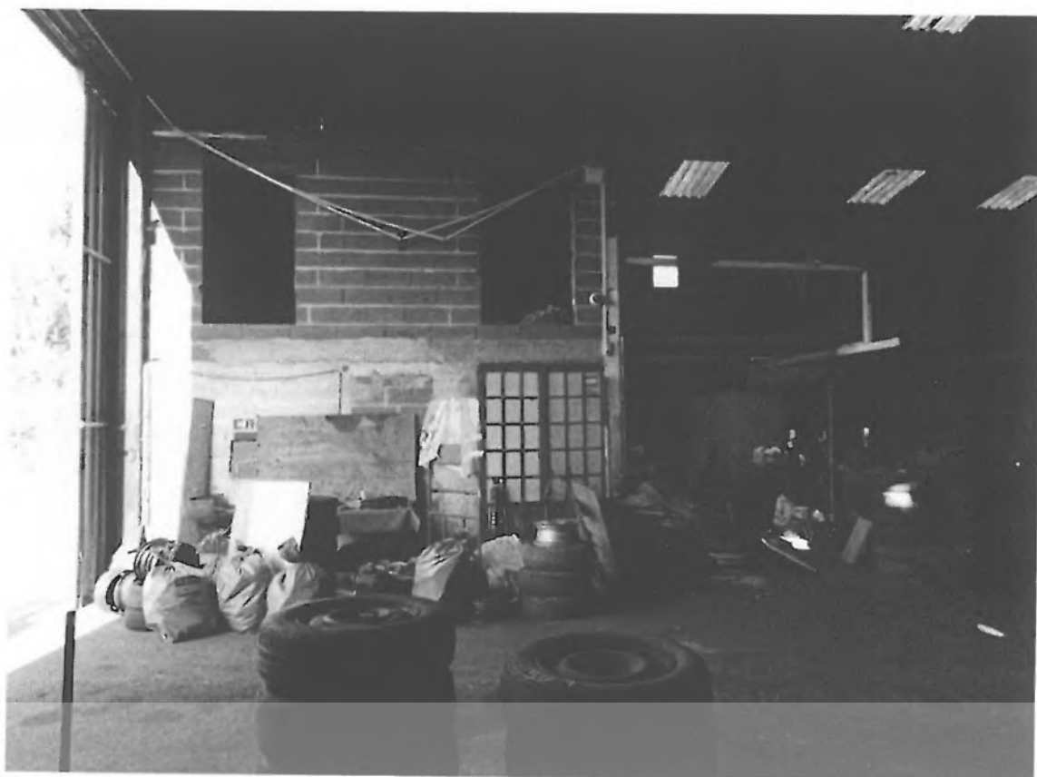
Vue de l'étage en construction
