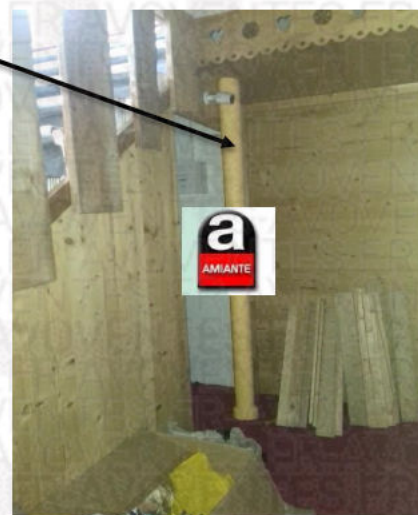
coffrages perdus de type fibre-ciment amiante
