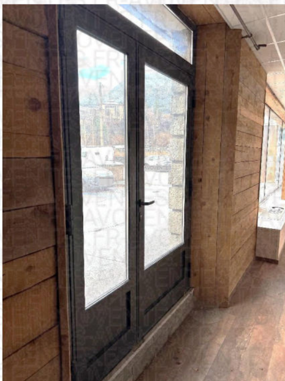
Partie Nord-Est du magasin :
