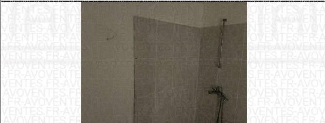
**Description :** Local contenant une baignoire ou une douche : l'installation électrique ne répond pas aux prescriptions particulières appliquées à ce local (adéquation entre l'emplacement où est installé le MATERIEL ELECTRIQUE et les caractéristiques de ce dernier – respect des règles de protection contre les chocs électriques liées aux zones).
