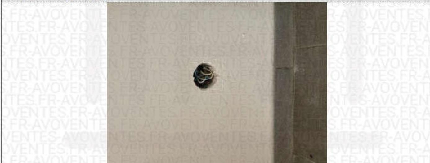
**Description :** L'installation électrique comporte au moins une CONNEXION avec une partie active nue sous tension accessible.
