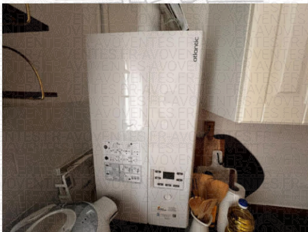
Chauffage : individuel – chaudière ATLANTIC au gaz de ville installée dans la cuisine.
