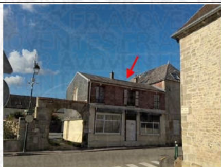
Photo n° PhA004 Localisation : toiture - toiture Ouvrage : Toitures Partie d'ouvrage : Ardoises (fibres-ciment) Description : Ardoises (fibres-ciment)
