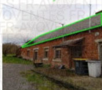
M001 - Ardoises (composites) Absence d'amiante
