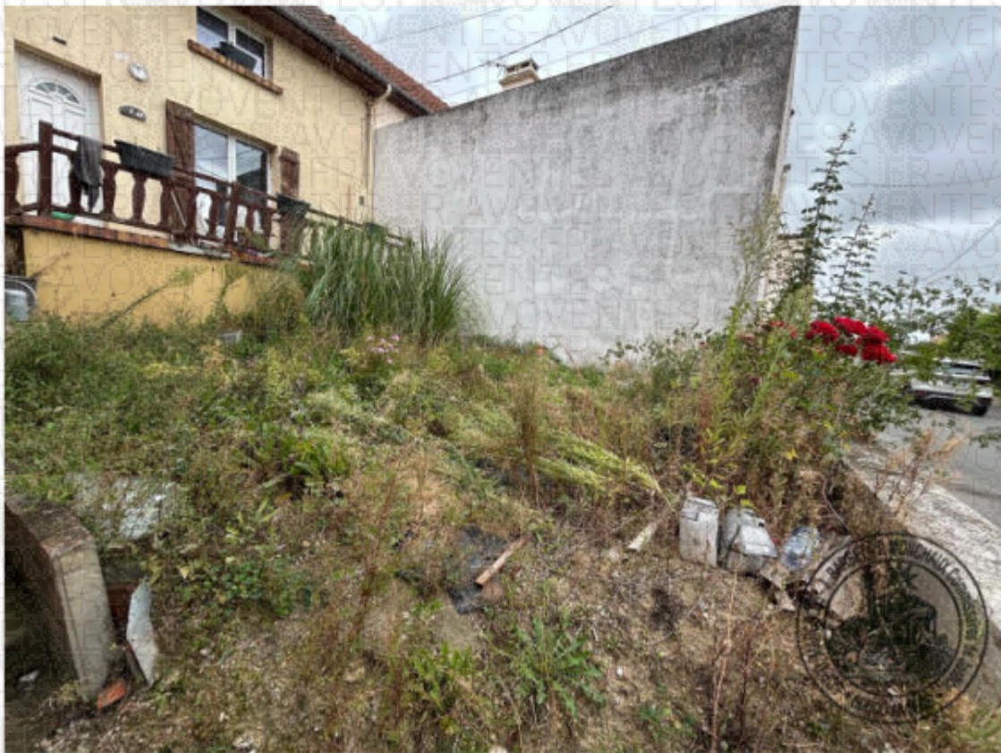
Façade arrière de la maison :
