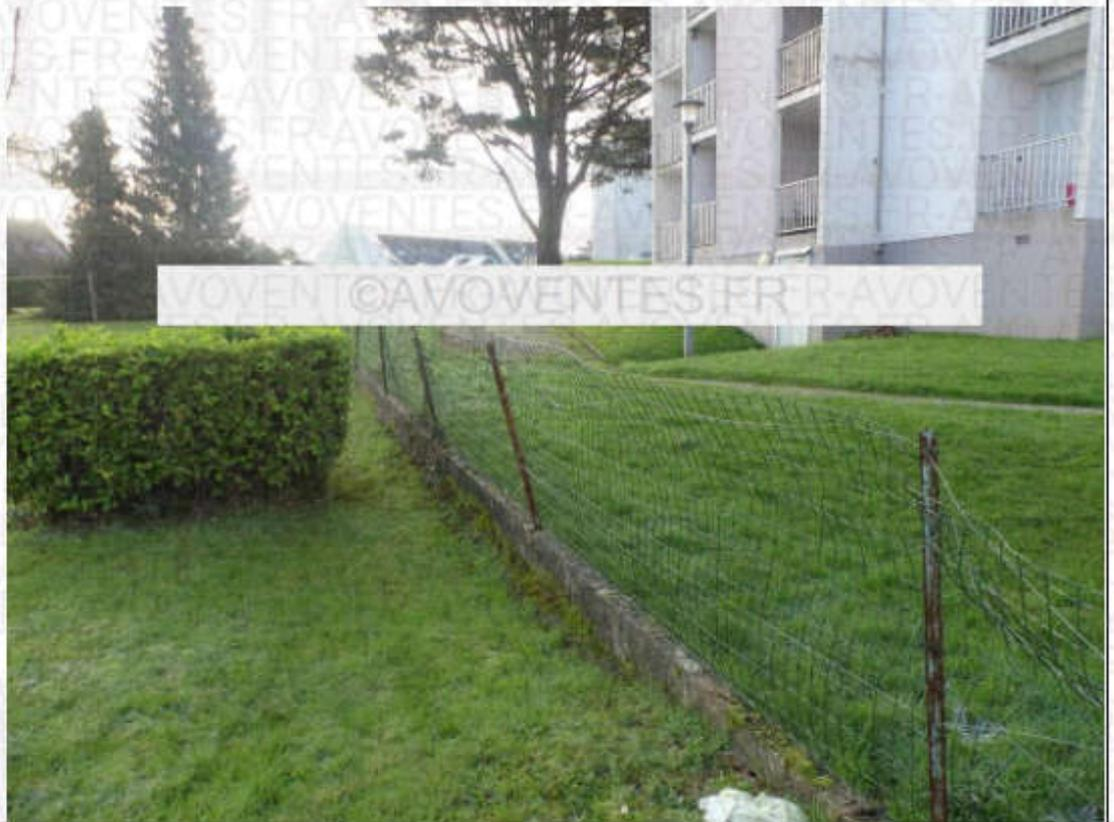
La limite Nord est matérialisée par une clôture composée d'un soubassement en agglos surmontés d'un grillage en fil de fer.
