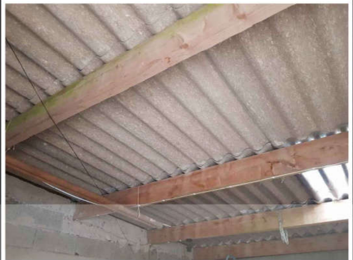
HANGAR double Vue intérieure
