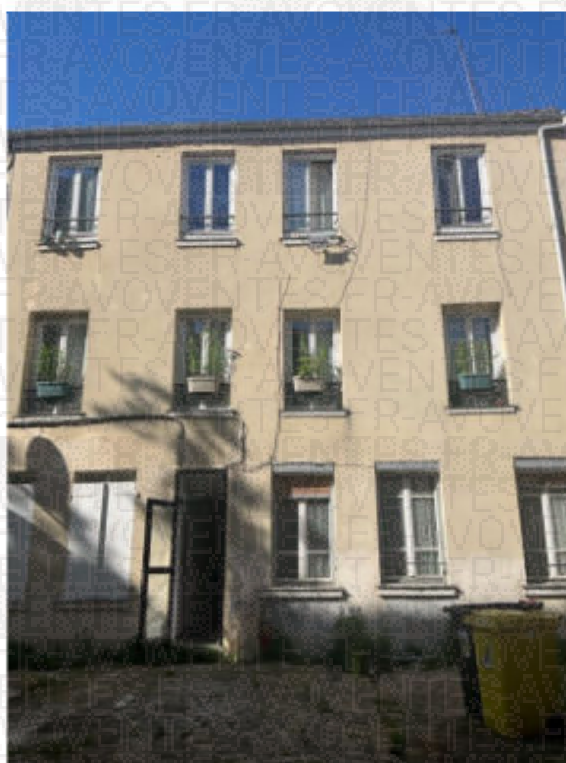
Immeuble situé en fond de cour séparant les deux bâtiments
