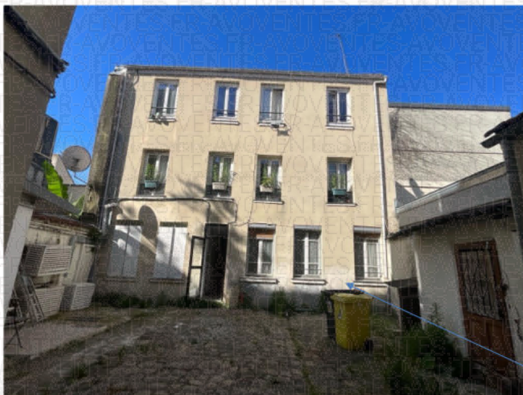
Emplacement de 'l'appartement : RDC droite
