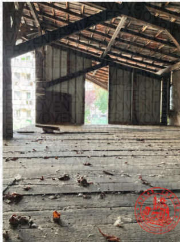
Étage de l'entrepôt
