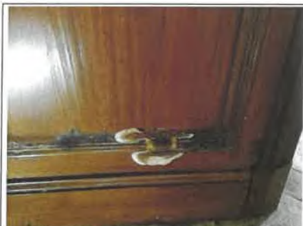
Photo n° PhTer004 Localisation : RdC - Hall Ouvrage : Soubassement bois Parasite : Champignon de pourriture cubique du type méréule pleureuse ( Serpula lacrymans )(humidité peu importante) Indices : présence de spore, présence de mycélium
