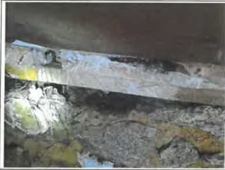
Photo n° PhTer001 Localisation : Gîte 2 - Chambre 3 Ouvrage : Murs Parasite : --- Champignons lignivores ---, Champignon de pourriture cubique du type méréle pleureuse ( Serpula lacrymans )(humidité peu importante) Indices : présence de mycélium
