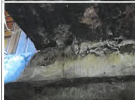
Photo n° PhTer002 Localisation : Sous-Sol - Cave 1 Ouvrage : Plafond bois Parasite : ---- Insectes à larves xylophages ----, Capricornes des maisons ( Hylotrupes bajulus ), Petites vrillettes ( Anobium punctatum ), --- Champignons lignivores ---, Champignon de pourriture cubique du type méréule pleureuse ( Serpula lacrymans )(humidité peu importante) Indices : dégradation du bois, présence de trous de sortie, présence de vermoulure, présence de mycélium (élément(s) fortement dégradé(s))
