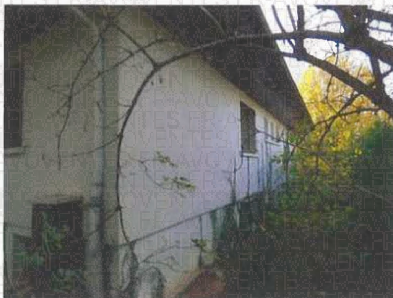
La façade Est est recouverte de crépi ton blanc, en état d'usage. Deux descentes de chéneau se situe en façade.
