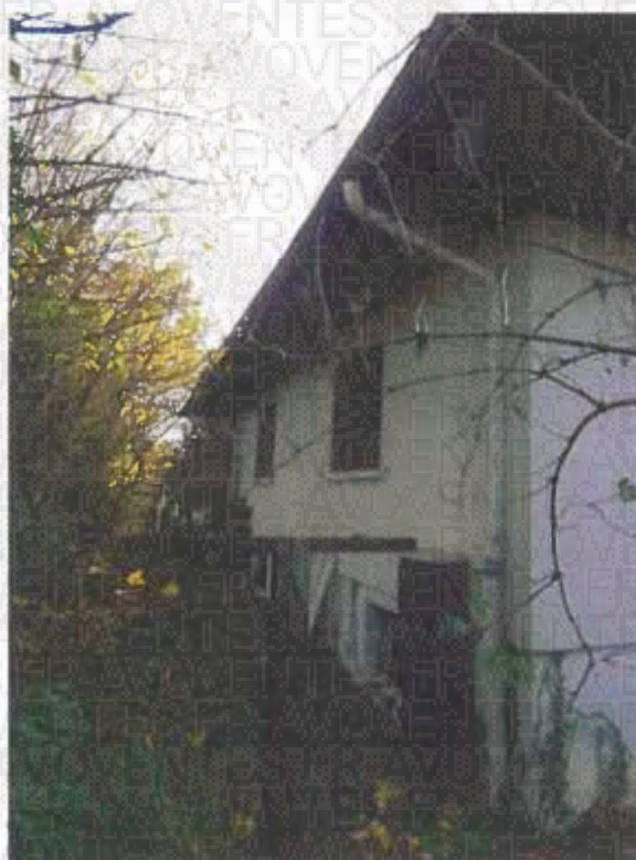
La façade Est est recouverte de crépi ton blanc, en état d'usage. Deux descentes de chéneau se situe en façade.
