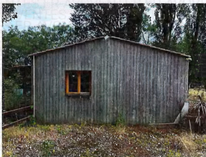
Vue d'ensemble de la maison ossature bois avec terrasse couverte, très dégradée avec toiture fuyarde et porte d'accès fracturée :
