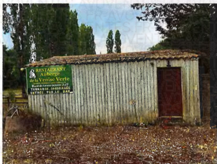
Vue d'ensemble de la maison ossature bois avec terrasse couverte, très dégradée avec toiture fuyarde et porte d'accès fracturée :
