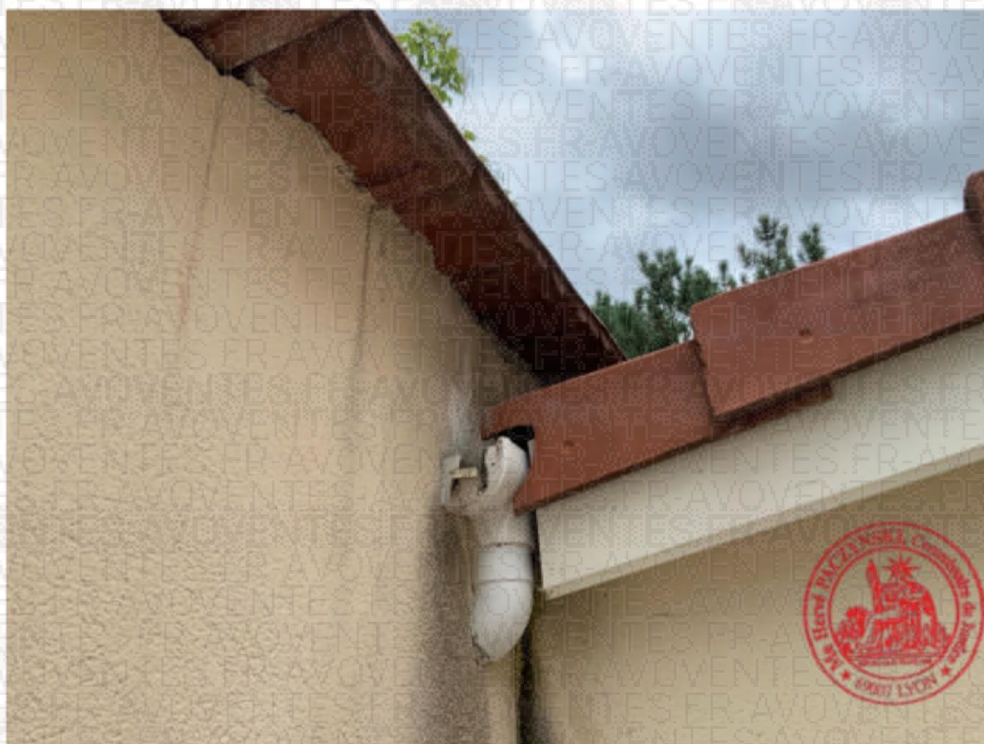
Je note des traces de coulures au mur et une fissure.
