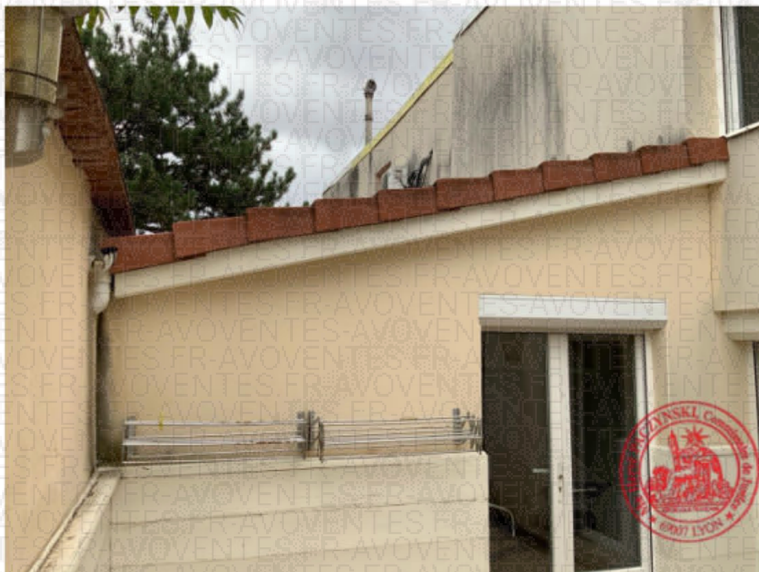
Je note des traces de coulures au mur et une fissure.
